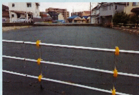
道路工事中断箇所の砂埃、雑 草対策に養生シートが (幸原)
