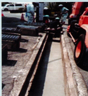
堆積する汚泥解消。 側溝改良工事実施 (谷田)
