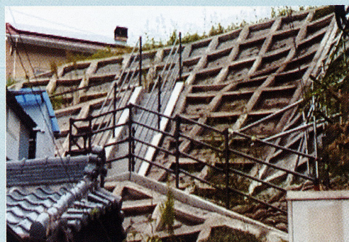
五万坂土砂崩落対策工事実施
